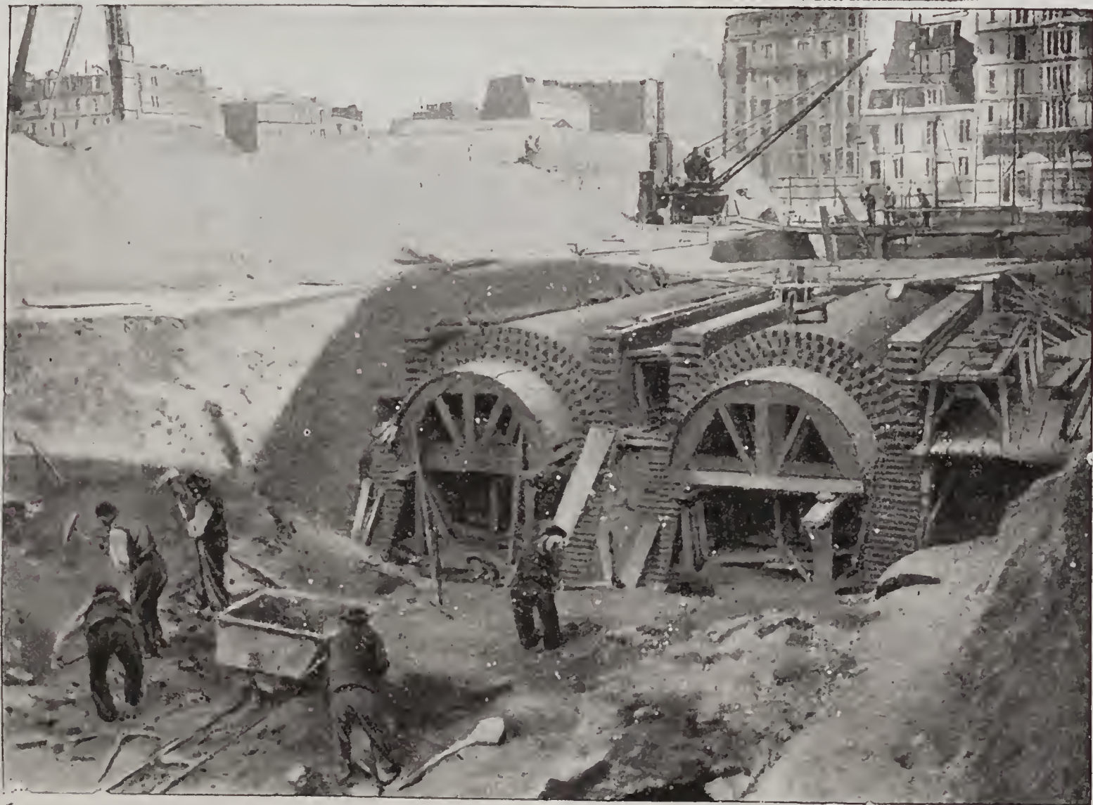
LE SERVICE DE PRODUCTION DE VAPEUR A L'EXPOSITION. — 1. Battage de pilotis pour les fondations de la cheminée de 80 mètres de hauteur. — 2. Construction des carneaux pour l'évacuation des fumées.
